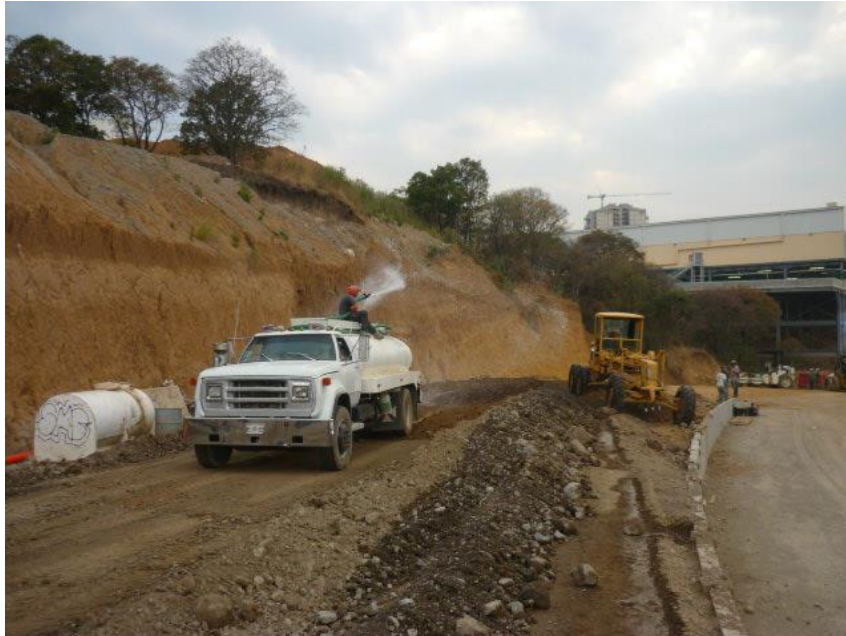
FOTOGRAFÍA 22.- EL CUIDADO QUE SE TENGA CON EL SUMINISTRO DE AGUA FACILITARÁ LA COMPACTACIÓN DE LOS SUELOS. ES IMPORTANTE QUE EL AGUA SEA POTABLE, ASIMISMO, QUE LA HUMEDAD SEA UNIFORME EN TODA LA MASA DEL SUELO. SEGÚN SEA LA VELOCIDAD DE LA PIPA, LOS RIEGOS PODRÁN SER LIGEROS PARA ADICIONAR POCO AGUA O PESADOS PARA UN INCREMENTO MAYOR EN SU CONTENIDO DE AGUA.
