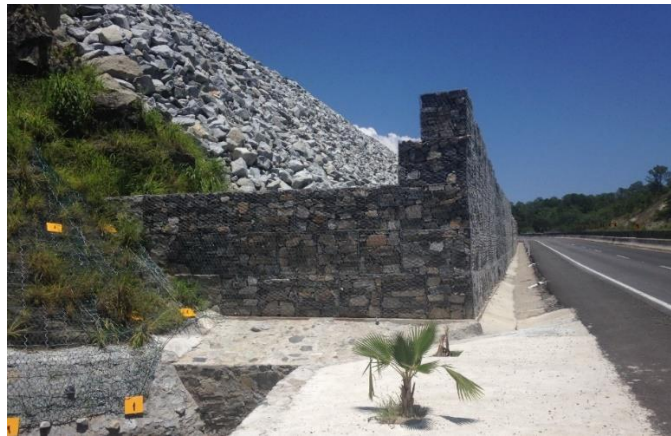
FUENTE: CORTESÍA DE MACCAFERRI FOTOGRAFÍA 9.- MURO ALCANCÍA, KM 301 CUERPO A, AUTOPISTA CUERNAVACA - ACAPULCO
