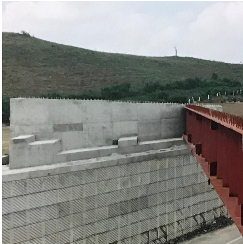
FUENTE: CORTESÍA DE MUROS TAI FOTOGRAFÍA 24.- MURO ESTRIBO MECÁNICAMENTE ESTABILIZADO CON REFUERZOS METÁLICOS.
