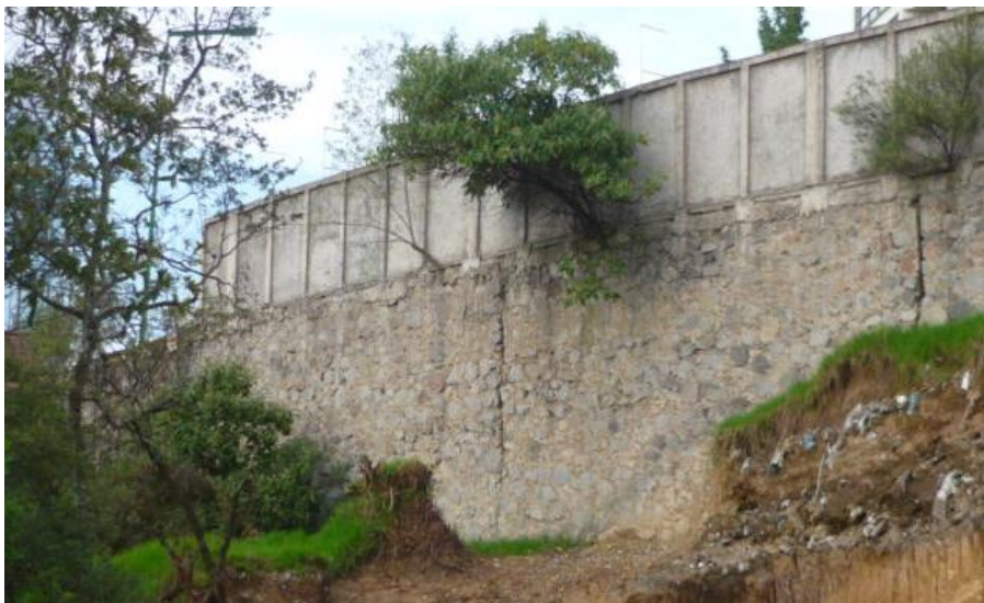
FOTOGRAFÍA 2.- MURO DE MAMPOSTERÍA, DE PIEDRA BRAZA DE HASTA 9.5 m DE ALTURA.
