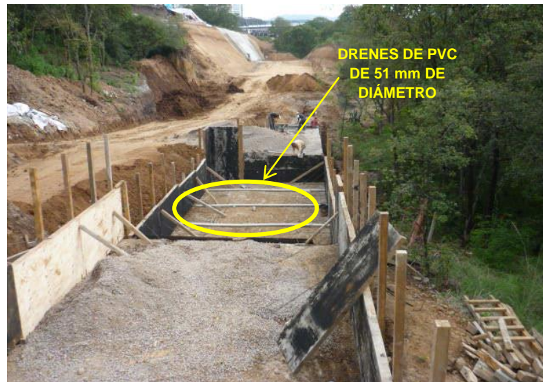
FOTOGRAFÍA 5.- INSTALACIÓN DE DRENES DE PVC EN UN MURO DE CONCRETO CICLÓPEO
