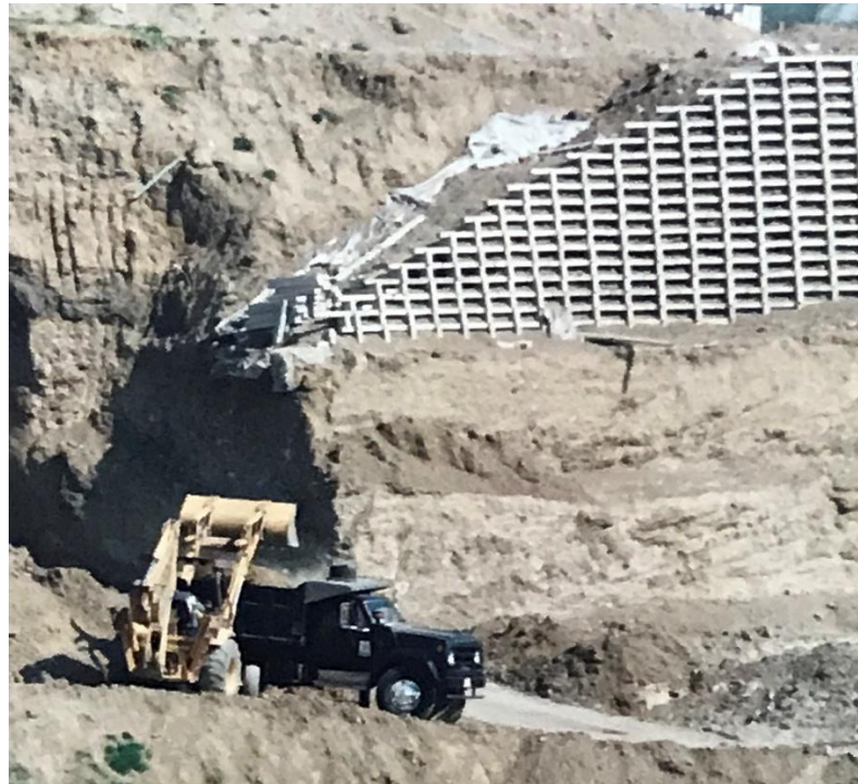
FOTOGRAFÍA 26.- MURO, CONSTA DE ELEMENTOS DE CONCRETO PREFABRICADOS QUE SE SOBREPONEN UNOS SOBRE DE OTROS DEJANDO CELDAS DE APROXIMADAMENTE 0.81 METROS CUADRADOS QUE SON RELLENADAS CON EL SUELO QUE CONFORMA EL MURO, POR EL CORTO ESPACIO LIBRE ENTRE ELEMENTOS PREFABRICADOS EL PROCESO DE COMPACTACIÓN SE DIFICULTA.
