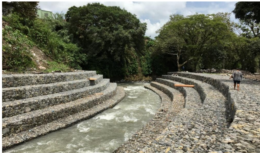
FUENTE: CORTESÍA DE MACCAFERRI FOTOGRAFÍA 8.- REVESTIMIENTO CON GAVIONES, RÍO ORIZABA, VERACRUZ
