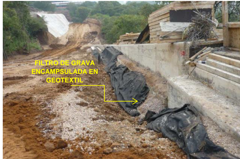
FOTOGRAFÍA 4.- FILTRO DE GRAVA ENCAPSULADA EN GEOTEXTIL, DENSIDAD 200 gcm -2
