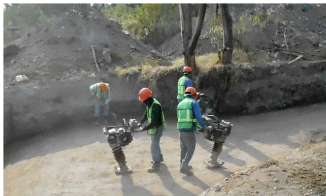
FOTOGRAFÍA 7.- COMPACTACIÓN CON BAILARINA PATA DE ELEFANTE
