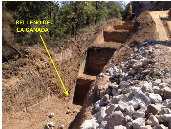
FOTOGRAFÍA 13.- DESPLANTE DE MURO DE CONCRETO CICLÓPEO. DADA LA EXISTENCIA DE UNA CAÑADA, RELLENA DE MANERA NATURAL, PARA EL DESPLANTE DEL MURO SE EXCAVÓ DE MANERA ESCALONADA PARA APOYAR AL MURO SOBRE TERRENO NATURAL. EN PRIMER PLANO SE OBSERVAN LAS ROCAS QUE SERÁN AVENTADAS PARA CONFORMAR EL CONCRETO CICLÓPEO.
