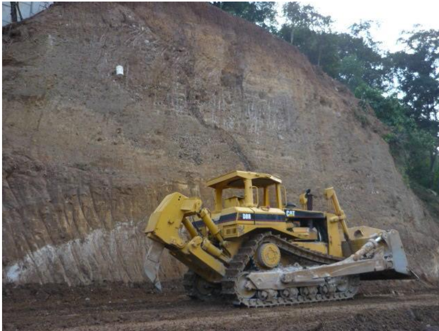
FOTOGRAFÍA 21.- SI EL SUELO ES GRANULAR, CON PARTÍCULAS DE HASTA 100 mm, EL SUELO PUEDE SER "COMPACTADO" CON TRACTOR DE CADENAS. AQUÍ SE MUESTRA UN TRACTOR CATERPILLAR D8R CON PESO DE 335 KN.
