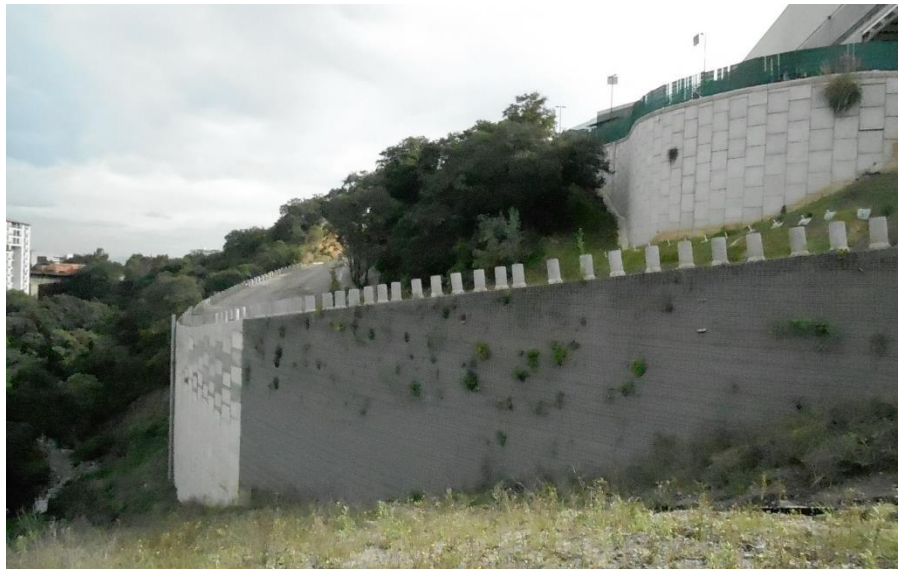
FOTOGRAFÍA 1.- MUROS MECÁNICAMENTE ESTABILIZADOS, VIALIDAD VISTA REAL, HUIXQUILUCAN, ESTADO DE MÉXICO
