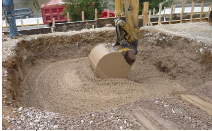
FOTOGRAFÍA 12.- MEZCLADO DE SUELO CEMENTO PARA MURO DE CONTENCIÓN, HUIXQUILUCAN, ESTADO DE MÉXICO
