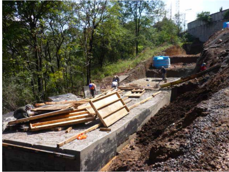
FOTOGRAFÍA 15.- DESCIMBRADO DE UNA SECCIÓN DE UN MURO DE CONCRETO CICLÓPEO. EN ESTE CASO LAS SUPERFICIES DE LAS DISTINTAS ETAPAS DE LOS COLADOS SE DEJO ÚNICAMENTE EN CONTRAPENDIENTE Y RUGOSAS. LAS PIEDRAS NO SOBRESALIERON.
