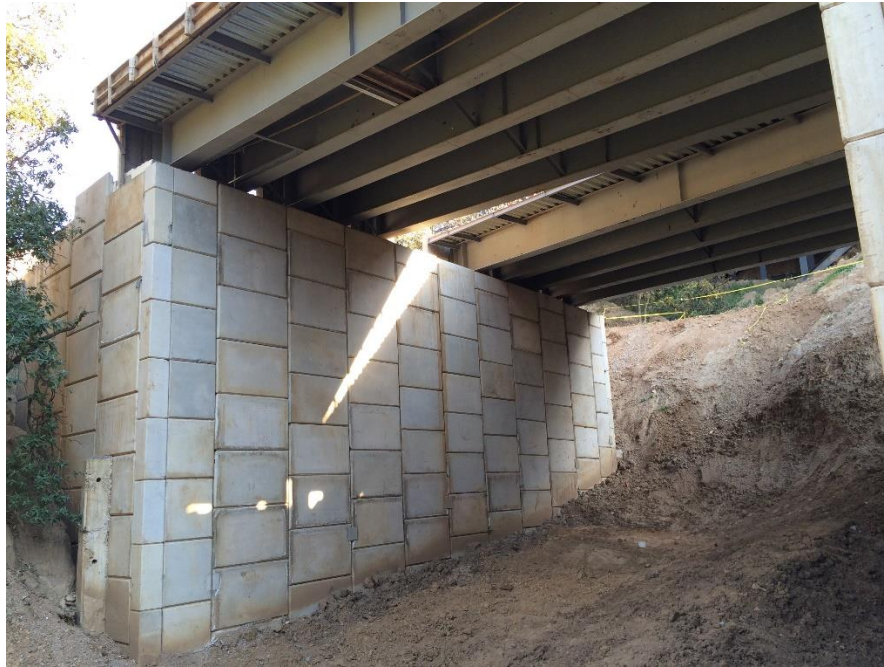
FOTOGRAFÍA 3.- MURO MECANICAMENTE ESTABILIZADO ESTRIBO DE PUENTE VEHICULAR
