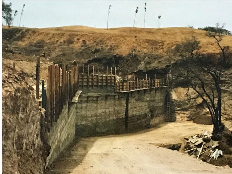
FOTOGRAFÍA 25.- MURO DE SUELO – CEMENTO. EL SUELO SE CLASIFICÓ COMO ARENA LIMOSA, LOS LÍMITES DE CONSISTENCIA O DE ATTERBERG NO SE PUDIERON EFECTUAR DADA SU BAJA PLASTICIDAD. LA PROPORCIÓN DE CEMENTO FUE DE 2.5 SACOS DE CEMENTO PORTLAND PUZOLANA POR CADA METRO CÚBICO DE SUELO SUELTO.
